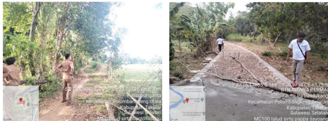
Foto: Kegiatan Pembangunan Jalan (Dinas PUTRPPK Kabupaten Takalar)
